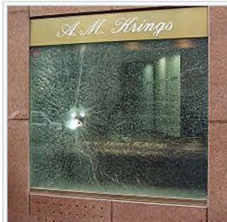
☞ Panzerglas-Schaufenster eines Juweliers nach einem Einbruchversuch.
